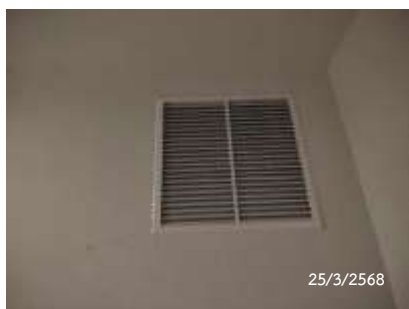
ช่องอัดอากาศ Fireman Lift
